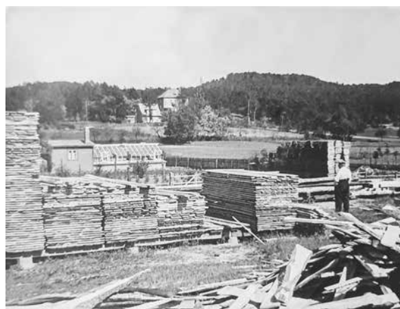
Blick auf das Baugeschäft und Sägewerk von Karl Noske, Liebenau, Schwiebusser Str. 111
