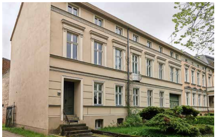
Wohnhäuser des Bürgermeisters in Neuruppin
