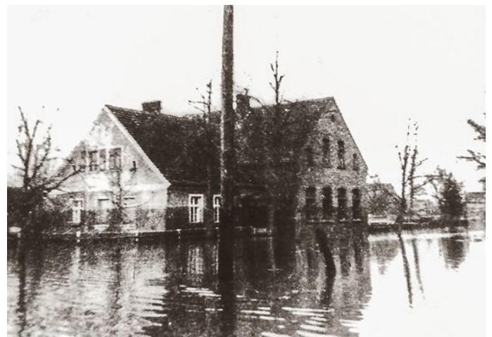
Schulhaus. Abgelaufenes Hochwasser, Höchststand des Hochwassers am Haus zu sehen
