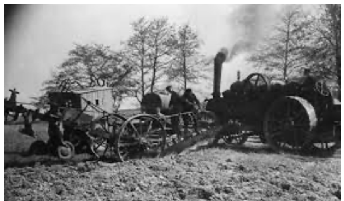
Zwei Dampfmaschinen standen sich je am Rand des Feldes gegenüber. Zwischen den Maschinen waren Stahlseile gespannt, mit denen ein riesiger Pflug, der immer wieder mit 5 oder 6 bis 10 Flugscharen hin und her gezogen wurde. (Bundesarchiv Bild 183-S78768, Oderbruch, Frühjahrsbestellung, Einsatz einer Lokomobile.jpg – Wikimedia)
