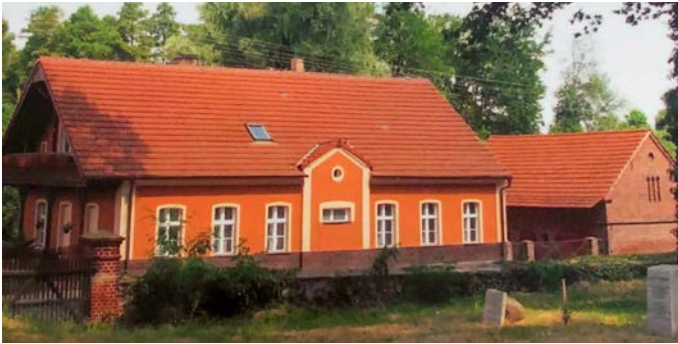
2010 Das Schulhaus ist heute ein Wohnhaus in Klemzig
